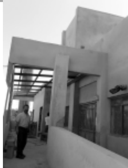
Obras aceleradas no Sindicato
